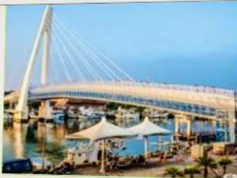
สะพานคู่รักต๋ันส่วย
