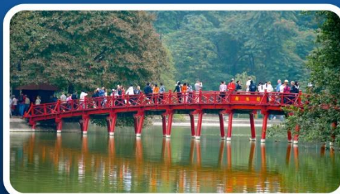
สะพานแสงอาทิตย์
