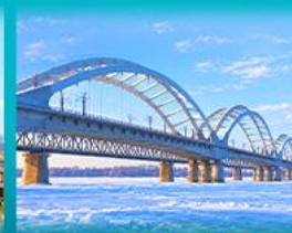
สะพานรถไฟโปนิว
